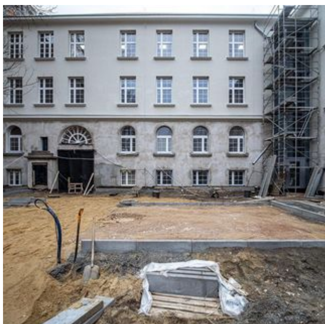
Kończymy remont generalny zabytkowej szkoły przy ul. Jaracza
