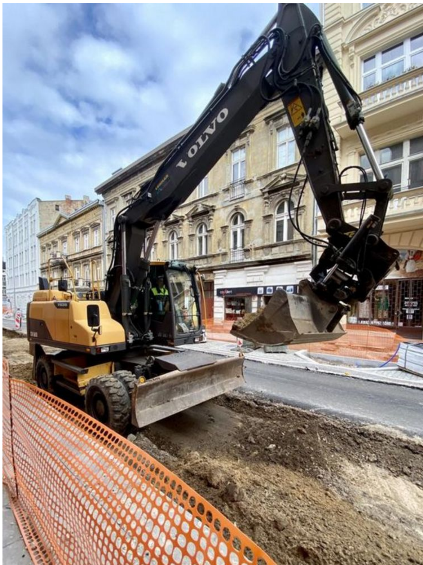
Półmetek prac przy przebudowie Próchnika i Rewolucji 1905 r.
