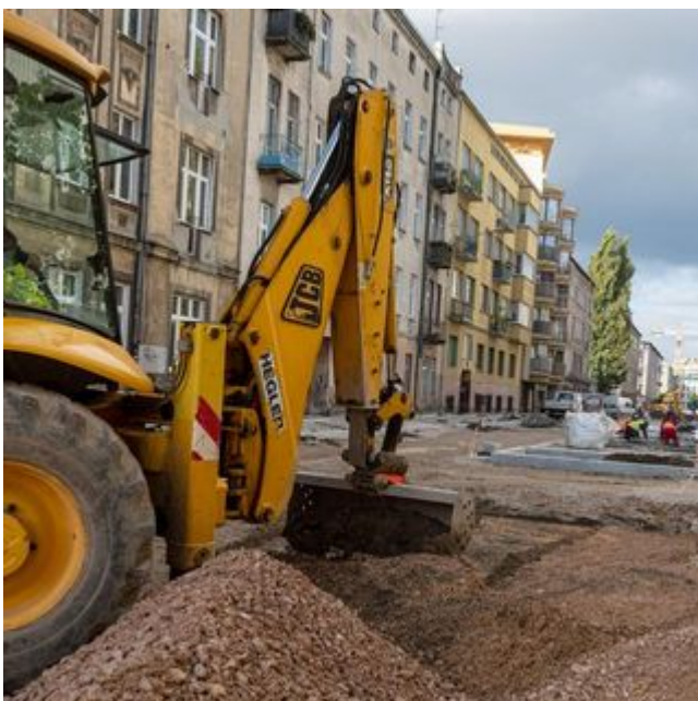
Przebudowa ul. Lipowej
