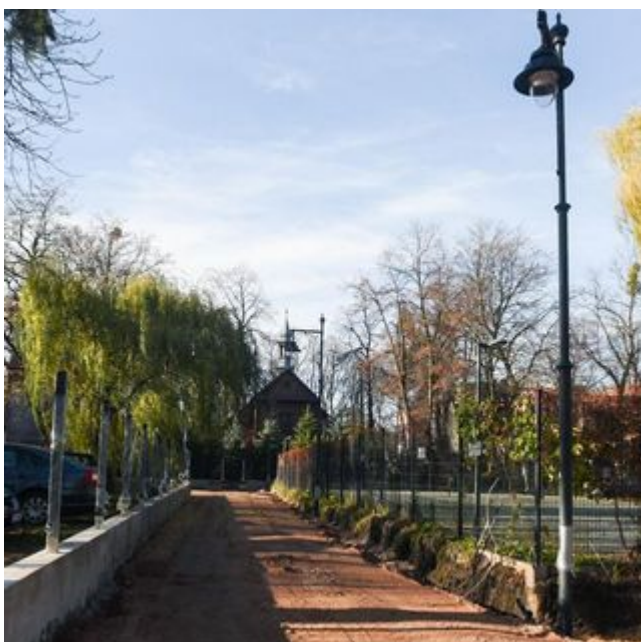
Trwa budowa nowych, zielonych pasażów koło Manufaktury
