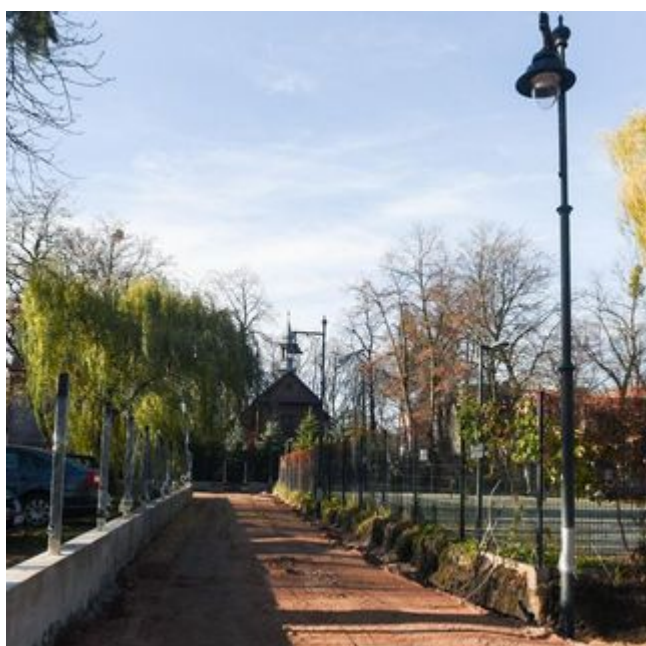
Trwa budowa nowych, zielonych pasażów koło Manufaktury
