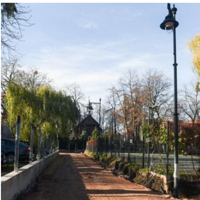
Trwa budowa nowych, zielonych pasażów koło Manufaktury
