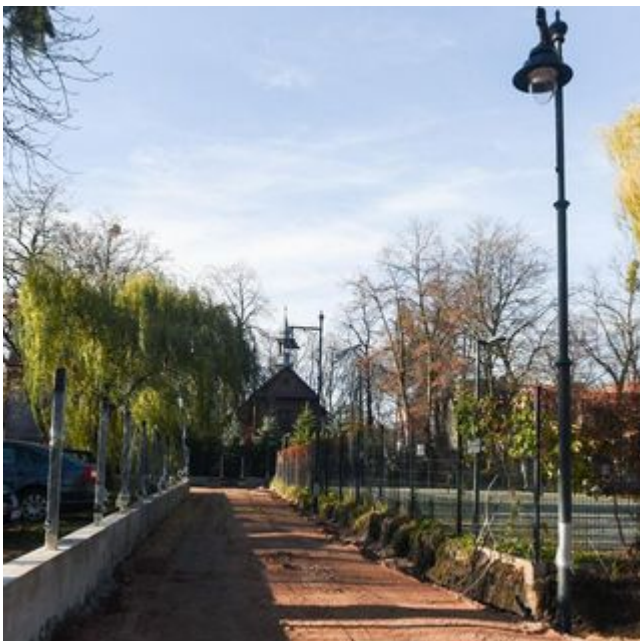
Trwa budowa nowych, zielonych pasażów koło Manufaktury
