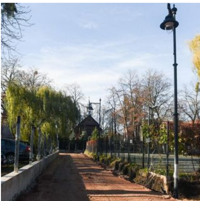
Trwa budowa nowych, zielonych pasażów koło Manufaktury
