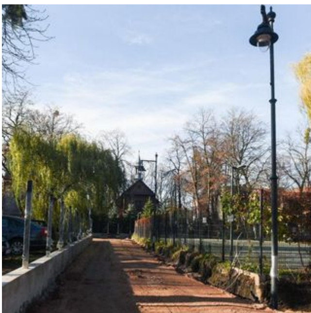
Trwa budowa nowych, zielonych pasaży koło Manufaktury
