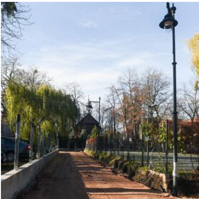
Trwa budowa nowych, zielonych pasażów koło Manufaktury
