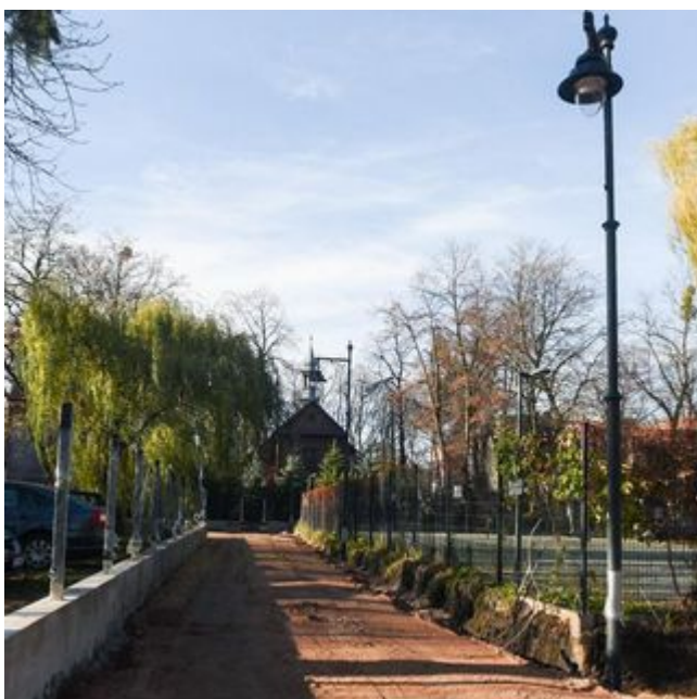
Trwa budowa nowych, zielonych pasażów koło Manufaktury
