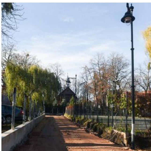
Trwa budowa nowych, zielonych pasażów koło Manufaktury
