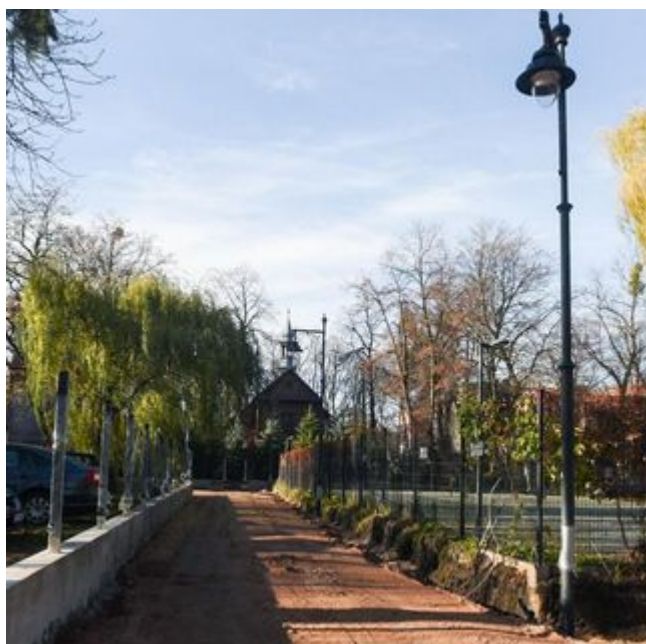
Trwa budowa nowych, zielonych pasażów koło Manufaktury
