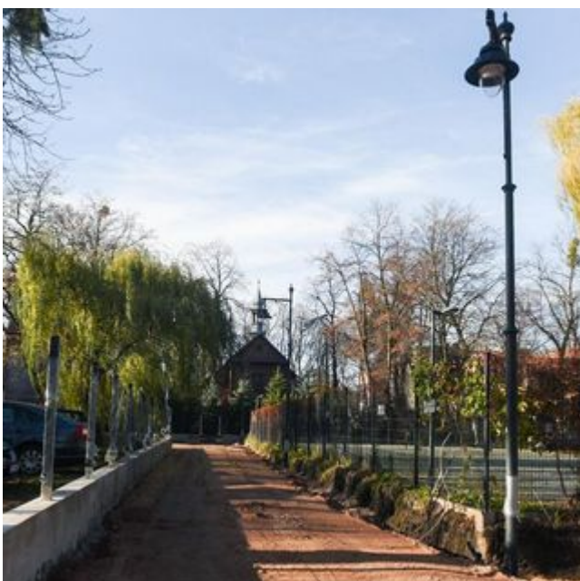
Trwa budowa nowych, zielonych pasażów koło Manufaktury
