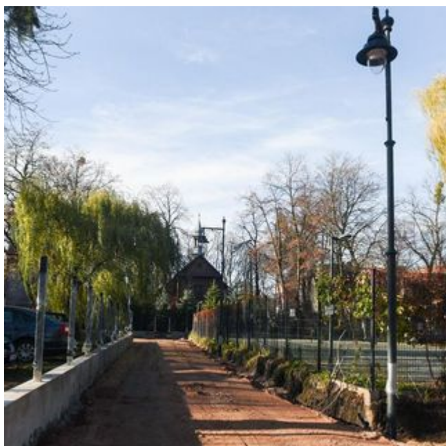
Trwa budowa nowych, zielonych pasażów koło Manufaktury
