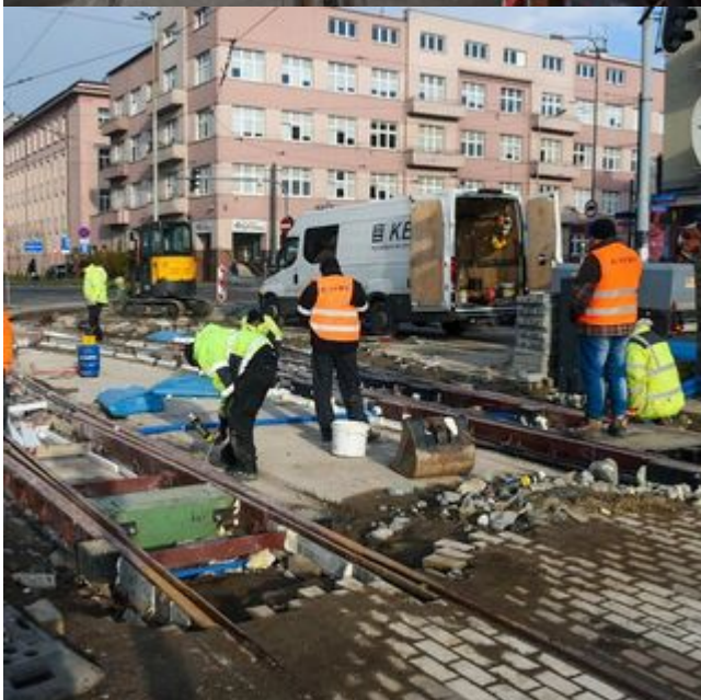
Kolejne etapy remontu na skrzyżowaniu Narutowicza / Kopcińskiego
