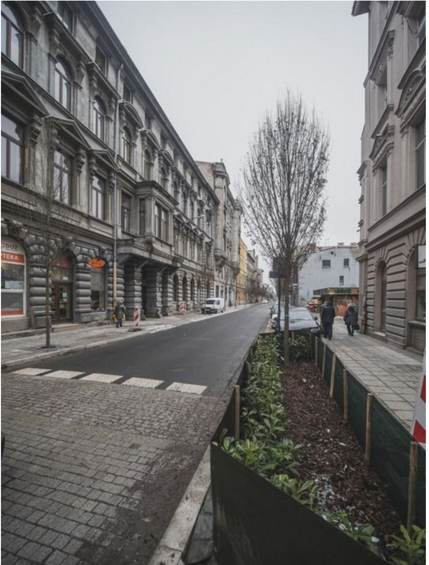
Ulica Próchnika i Rewolucji 1905 z zielenią i nową nawierzchnią. Wracają prace na ulicę Zachodnią
