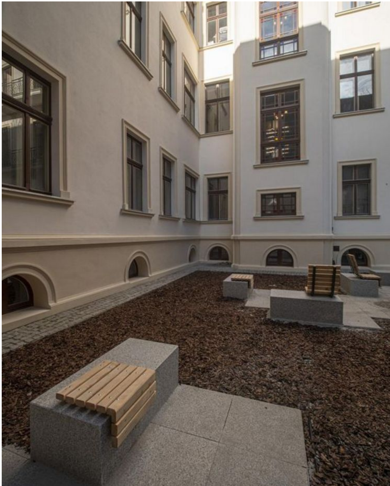
Zakończyliśmy generalny remont kolejnej zabytkowej kamienicy w centrum
