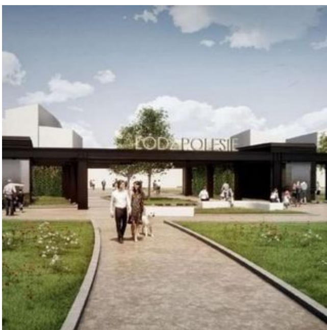
Startuje budowa stacji Łódź Polesie
