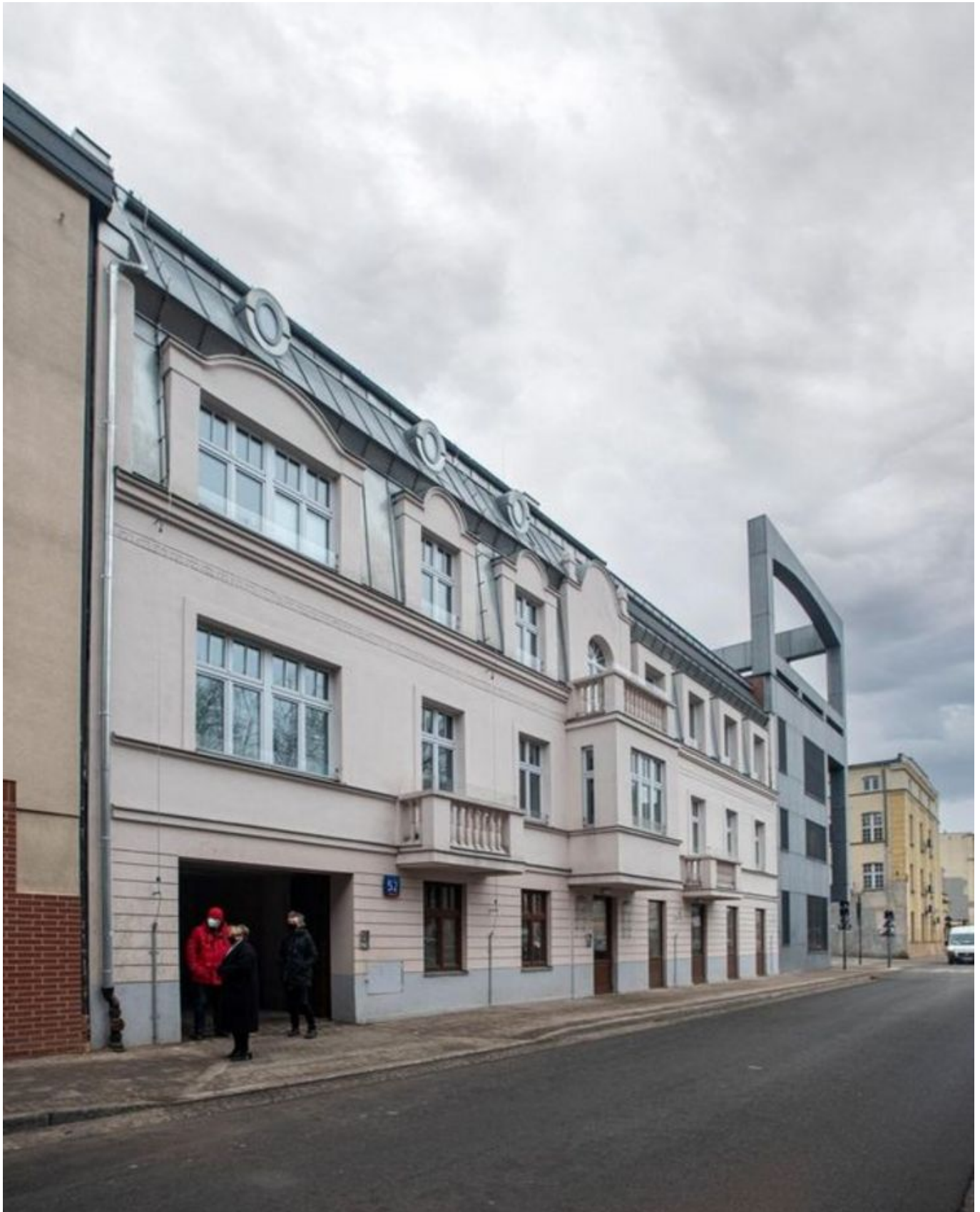
Do zrewitalizowanej dziewiętnastowiecznej kamienicy przy ul. Tuwima wprowadzili się najemcy i lokatorzy
