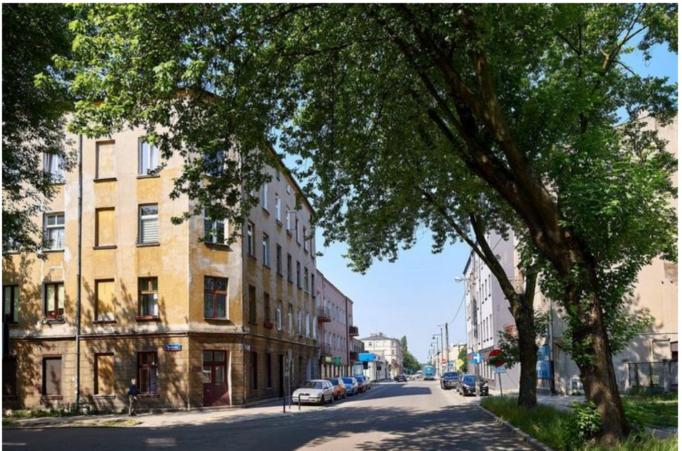
Remont ulicy Zarzewskiej na ostatniej prostej
