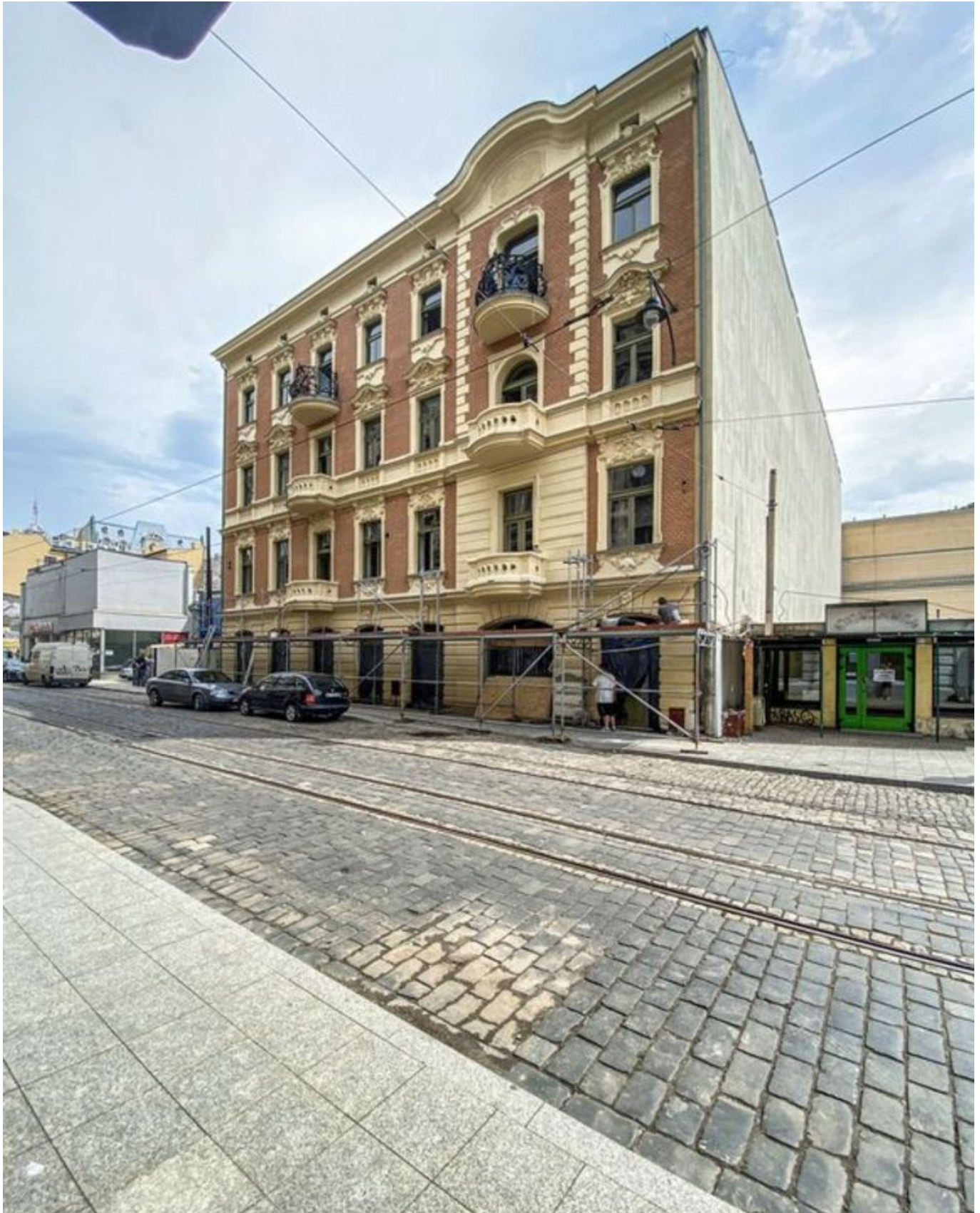
Elewacja kamienicy przy ul. Zielonej 6. widziana z poziomego przystanku
