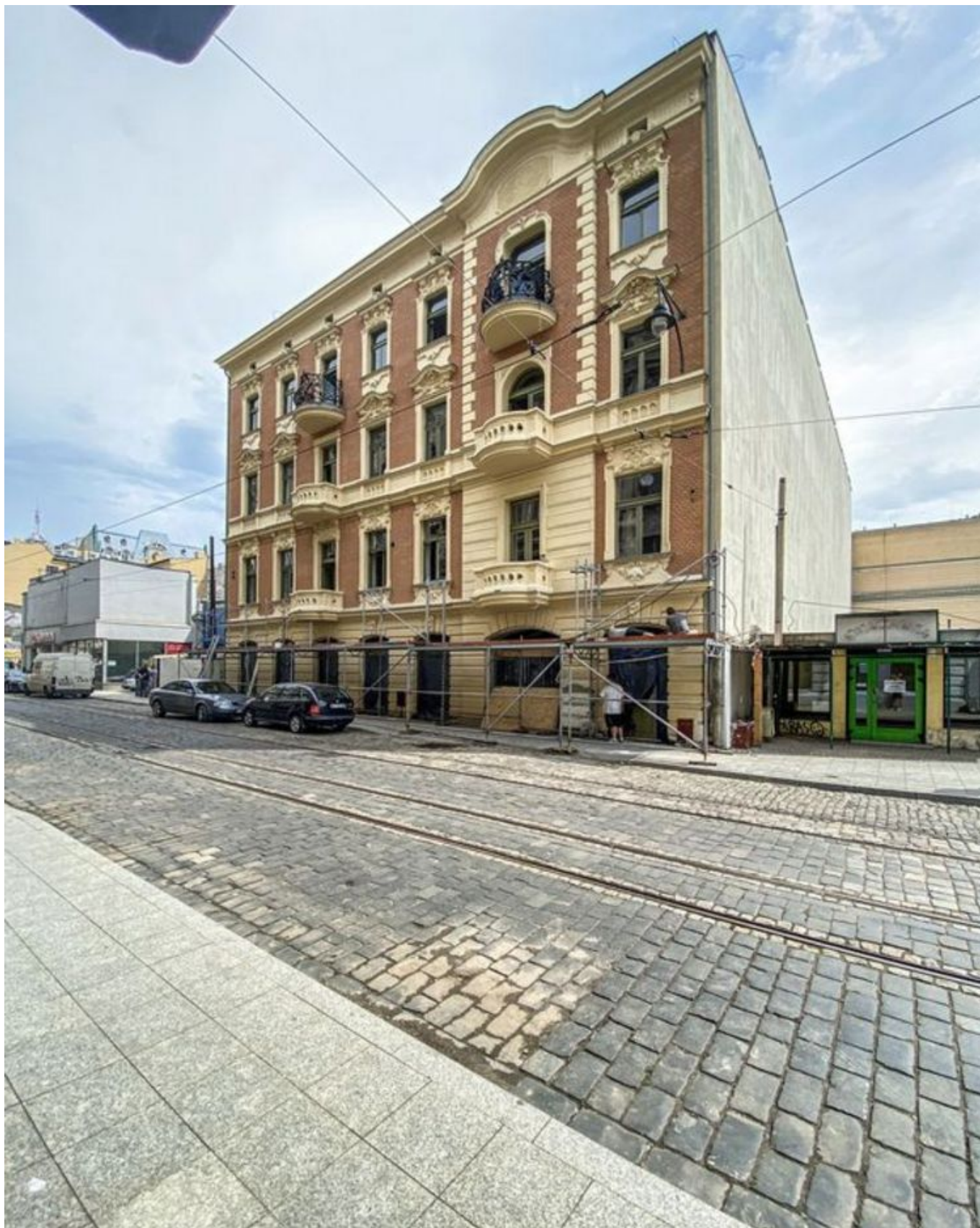
Elewacja kamienicy przy ul. Zielonej 6. widziana z poziomego przystanku
