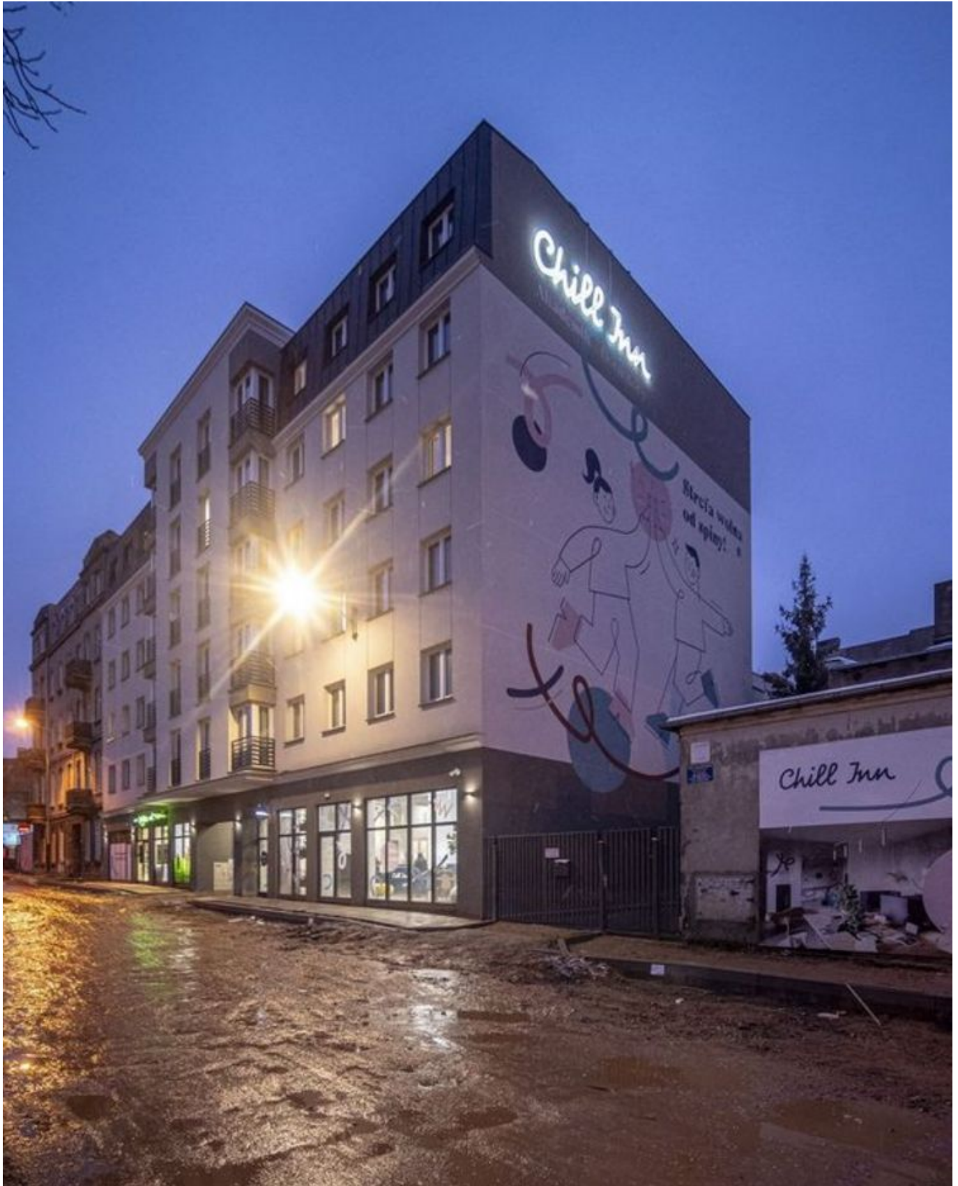
Widok na nowy akademik przy ul. 6-ego Sierpnia 70. Fotografia wykonana po zmroku
