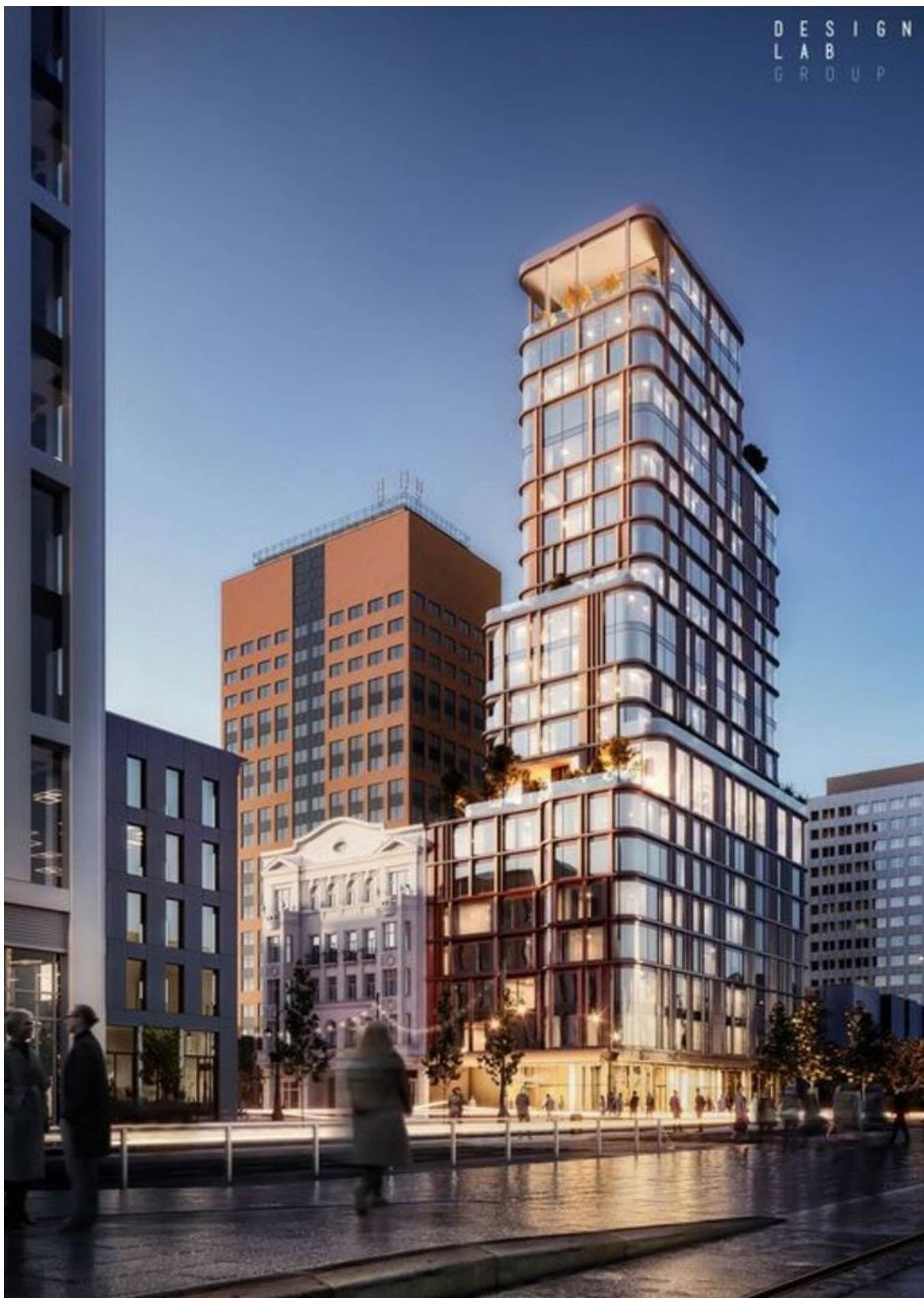
Wieżowiec Piotra Misztala. Jest zgoda na budowę 72-metrowego Golden Tower
