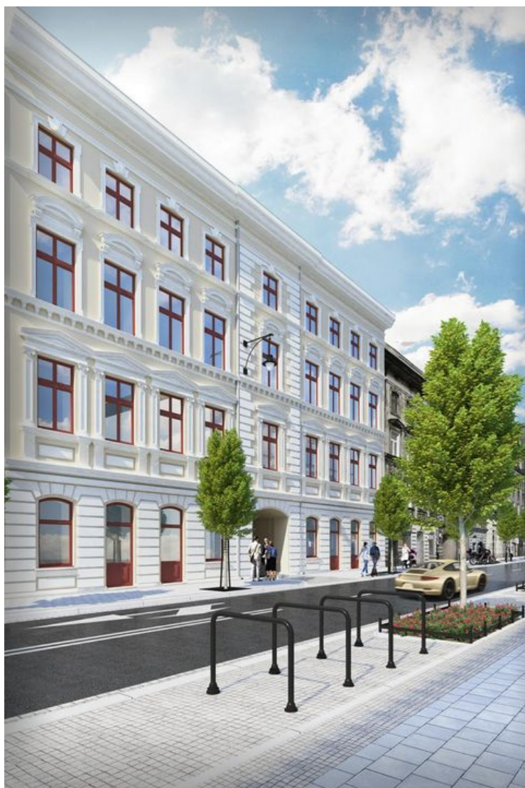
Remont trzech kamienic na Wschodniej. Co słychać na placu budowy? [ZDJĘCIA]
