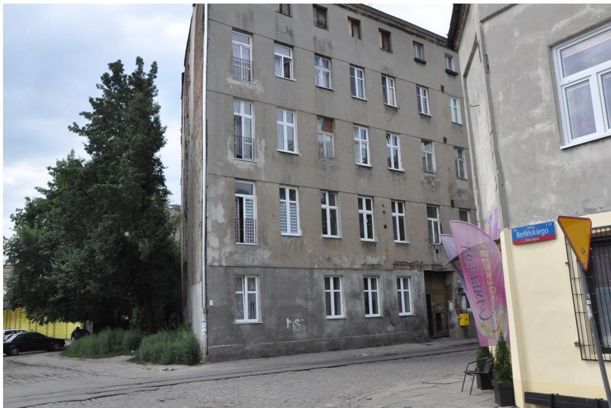
Ukośna ściana szczytowa kamienicy przy ul. Łagiewnickiej 8.
