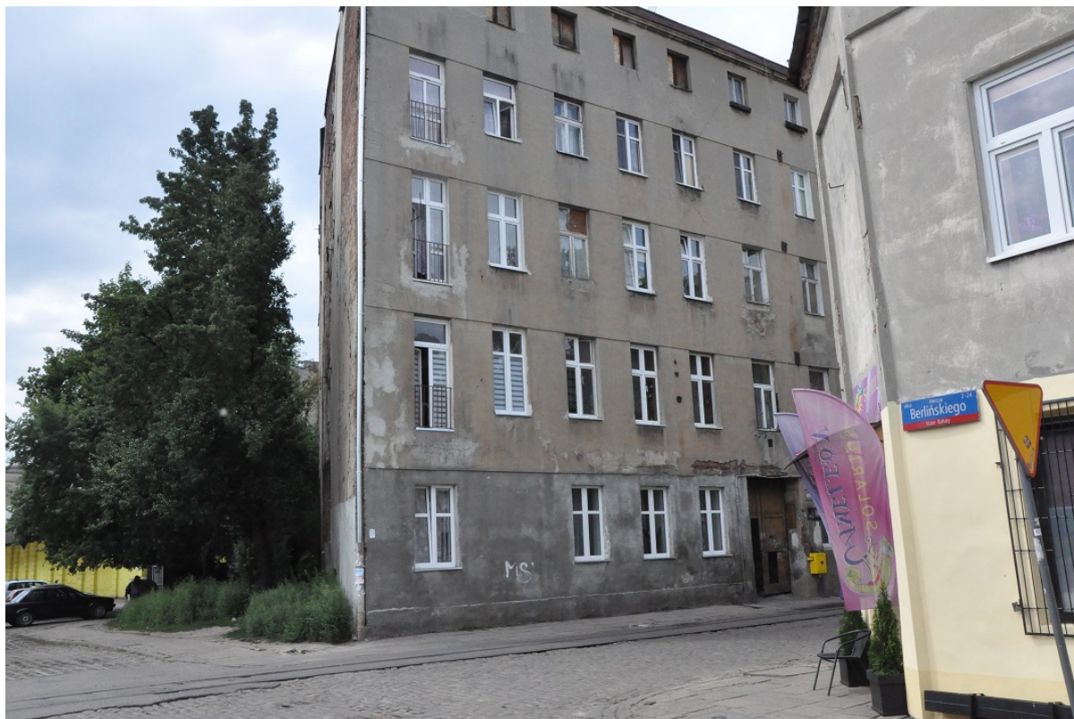
Ukośna ściana szczytowa kamienicy przy ul. Łagiewnickiej 8.
