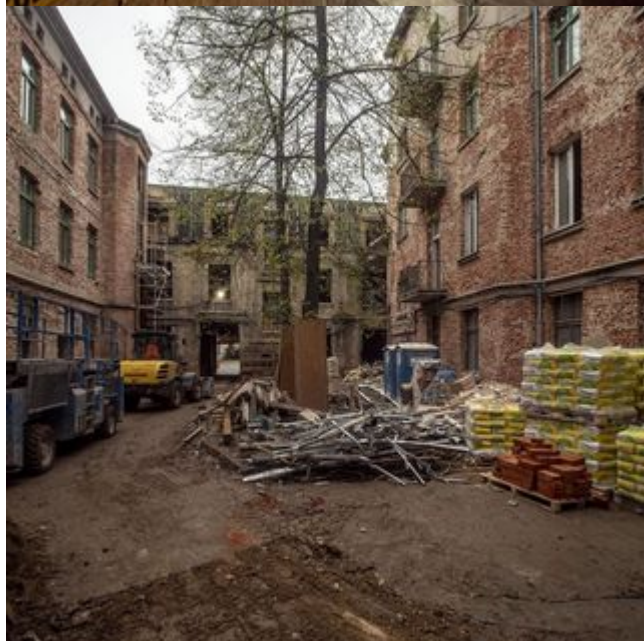
Rewitalizacja kamienicy przy Legionów 20. Ta ruina jeszcze nas zachwyci [ZDJĘCIA]
