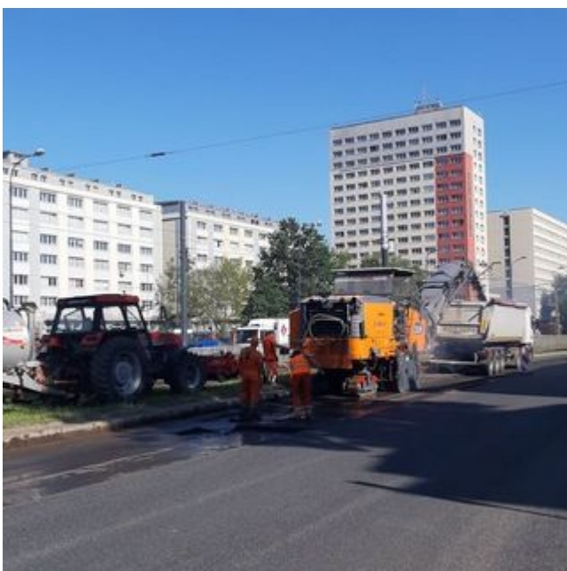
Politechniki i Żeromskiego w remoncie. Widać postępy w pracach [ZDJĘCIA]
