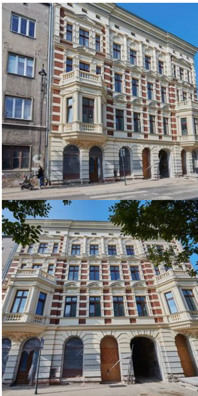
Kamienica przy Wschodniej 45 na półmetku remontu. Elewacja zachwyca [ZDJĘCIA]
