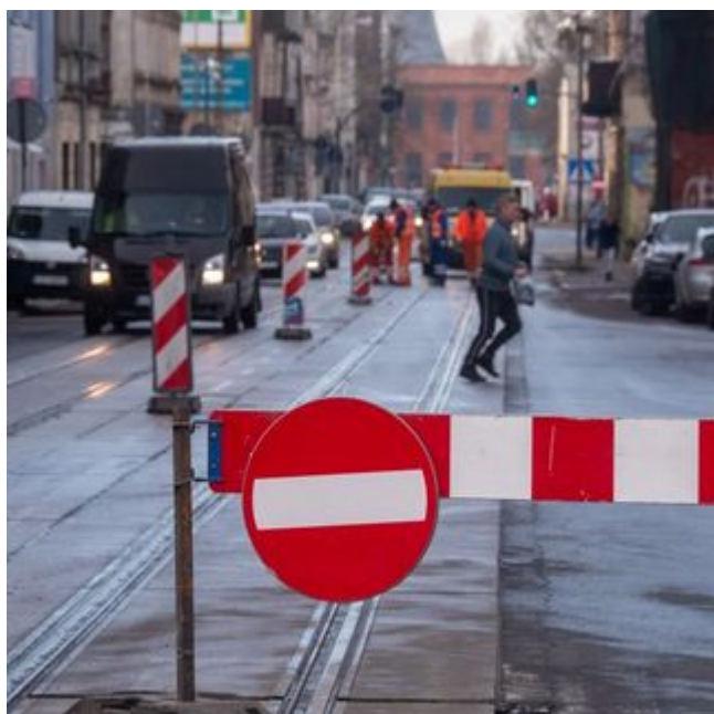
Zaczął się remont Przybyszewskiego. Robotnicy są już na placu budowy [ZDJĘCIA]
