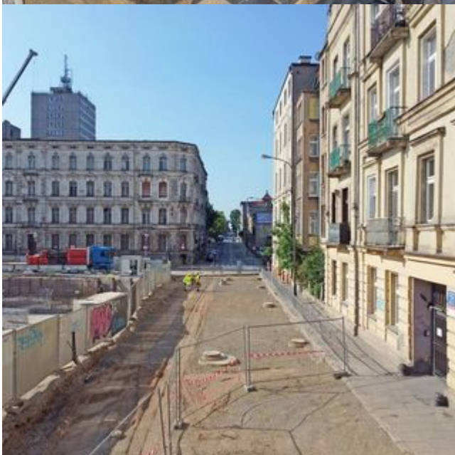
Budowa tunelu średnicowego pod Łodzią. Inwestycja PKP spowoduje kolejne zmiany w ruchu
