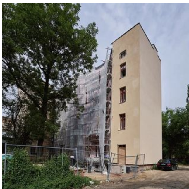
Rewitalizacja. Trzy kamienice przy Mielczarskiego w remoncie. Jak przebiegają prace?
