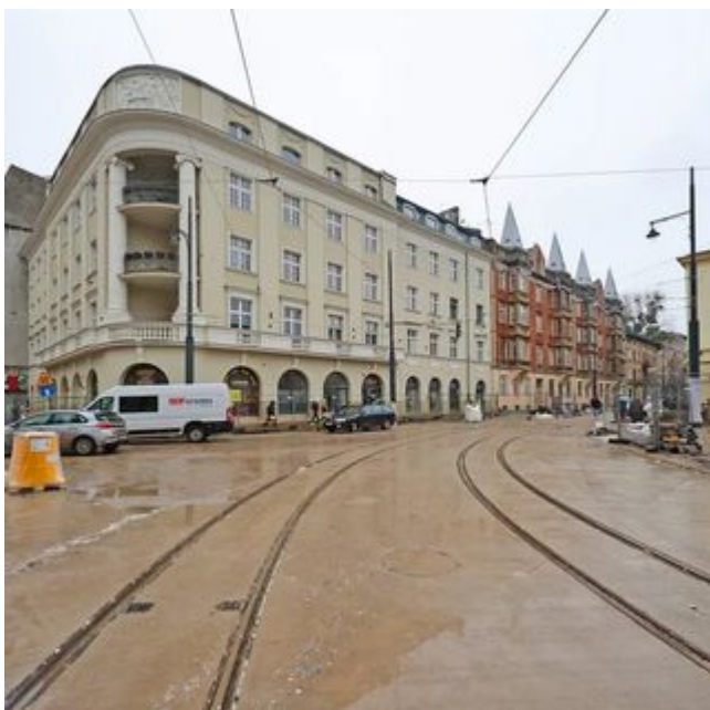
Remont Legionów. Torowisko na skrzyżowaniu z Gdańską połączone! [ZDJĘCIA]
