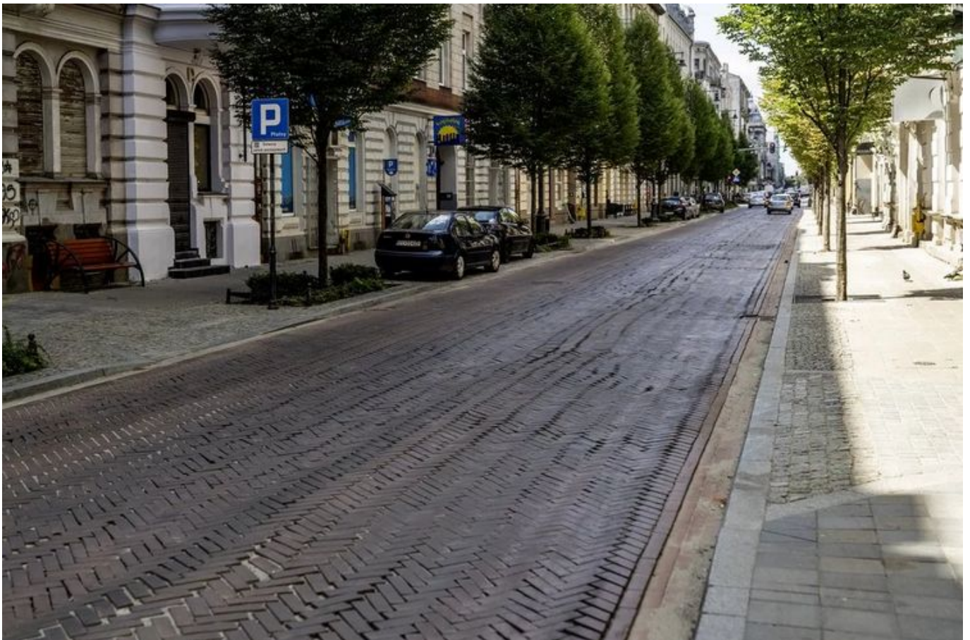
Remont Jaracza. Kiedy rozpoczną się prace nad nową nawierzchnią?
