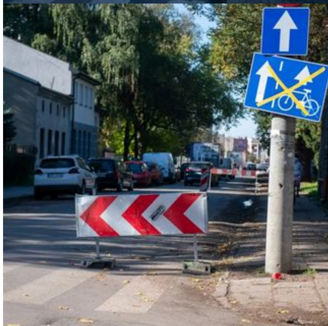
Remont trzech ulic przy Bałuckim Rynku rozpoczęty. Nowe jezdnie, chodniki, przystanki, ławki i drzewa
