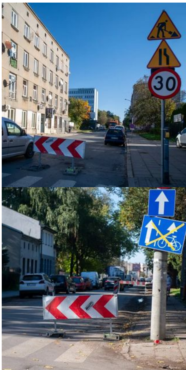
Remont trzech ulic przy Bałuckim Rynku rozpoczęty. Nowe jezdnie, chodniki, przystanki, ławki i drzewa
