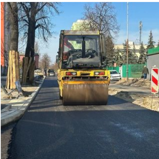
Remont Nowej w Łodzi. Pierwsza warstwa asfaltu i chodnik już widoczne [ZDJĘCIA]
