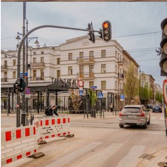
Remont Jaracza w Łodzi wkracza w kolejny etap. Ulica zostanie zamknięta dla ruchu [SZCZEGÓŁY]
