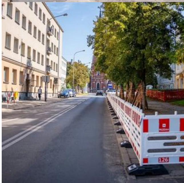
Remont Lutomierskiej w Łodzi. Są już wygrozdzenia, lada chwila start prac [ZDJĘCIA]
