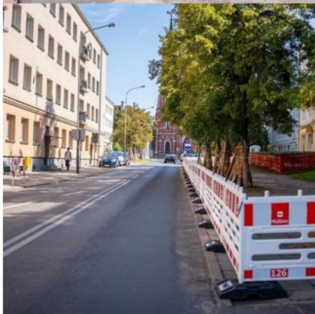
Remont Lutomierskiej w Łodzi. Są już wygrodzona, lada chwila start prac [ZDJĘCIA]
