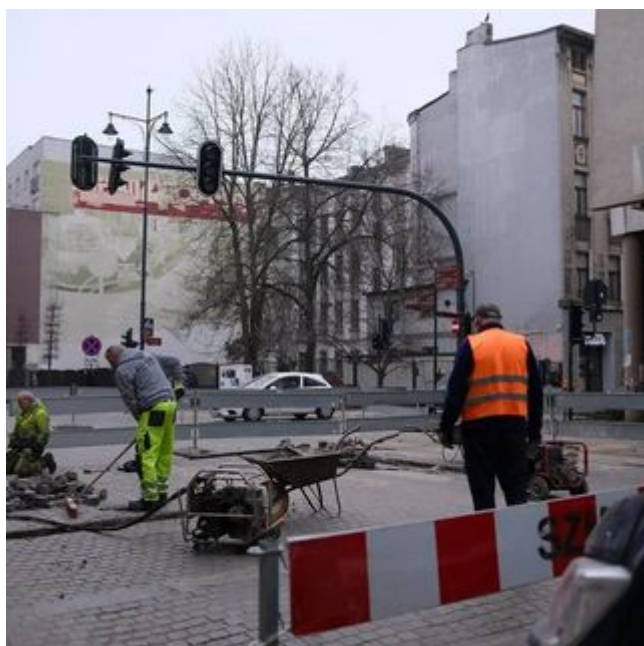
Remont skrzyżowania Nawrot i Sienkiewicza w Łodzi. Drogowcy naprawiają jezdnię [ZDJĘCIA]
