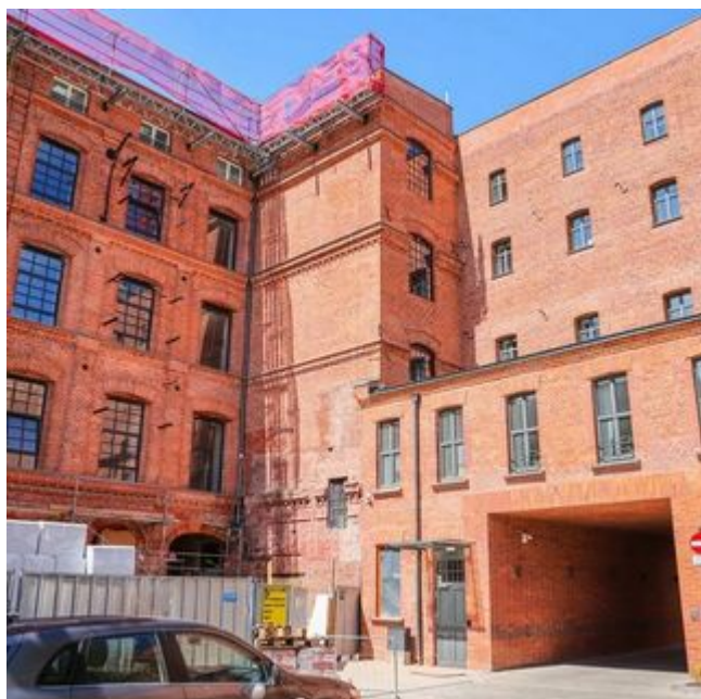
Remont fabryki przy Sienkiewicza. Nowe wnętrza, winda, schody i brama do budynków [ZDJĘCIA]
