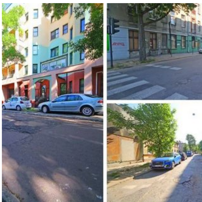
Remonty ulic przy Wodnym Rynku wystartowały! Odnowią Dobrą, Żółtą i Wysoką! [ZDJĘCIA]
