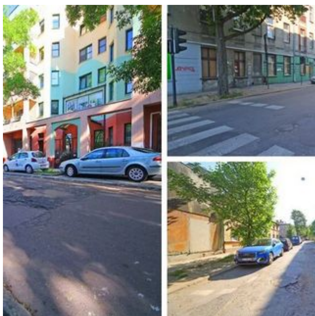
Remonty ulic przy Wodnym Rynku wystartowały! Odnowią Dobrą, Złotą i Wysoką! [ZDJĘCIA]
